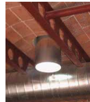
(C) DIFFUSORE SOSPESO per tetti curvi o inclinati
